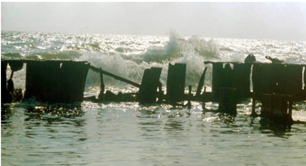
Reste der schützenden Stahlspundwand am Lobber Ufer, 1978
