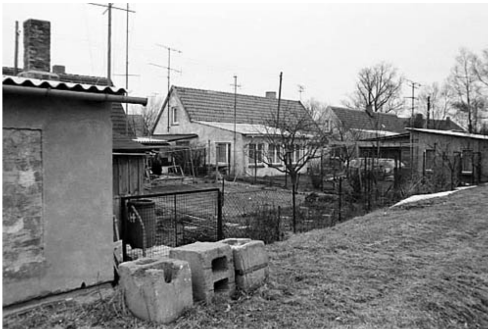
1944 und Anfang 1945 erbaute Lehmbauten der Marine, Winter 1981
